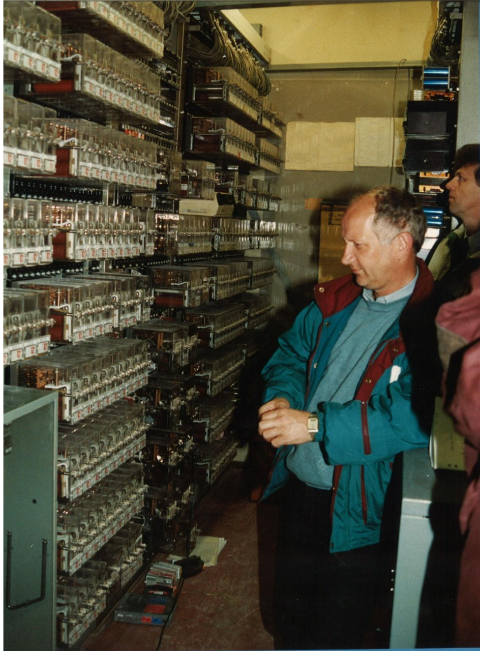
B-relais installatie te Hoorn
